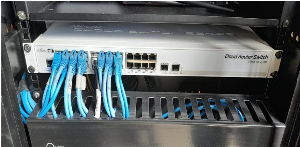
*Ilustración 3. Switch MikroTik instalado.*
