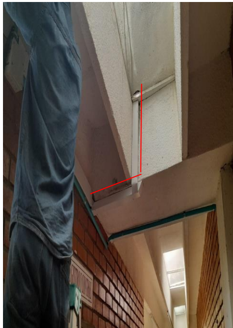
Ilustración 3. Recorrido de la canaleta.
