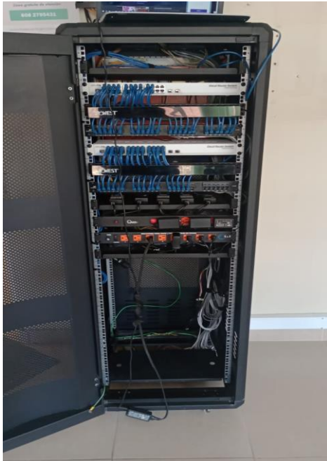
Ilustración 8. Visualización externa del nuevo DATA CENTER.
