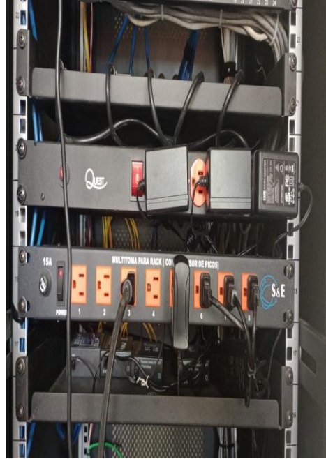
Ilustración 5. PDU Instalado.
