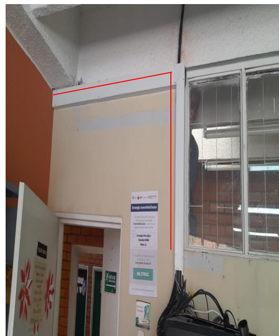
Ilustración 4. Recorrido de la canaleta.
