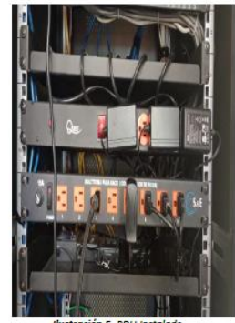
Ilustración 5. PDU instalado.
