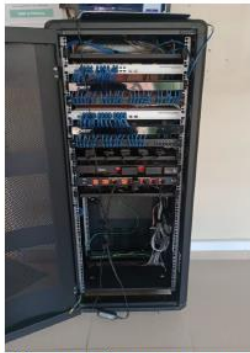
Ilustración 8. Visualización externa del nuevo DATA CENTER.
