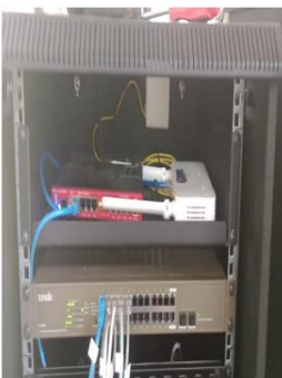
Ilustración 4. Maquillado de cableado.
