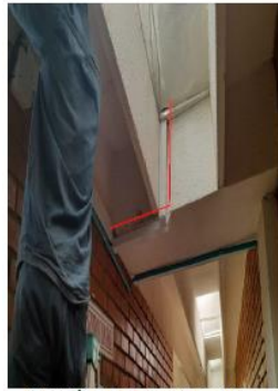
Ilustración 3. Recorrido de la canaleta.
