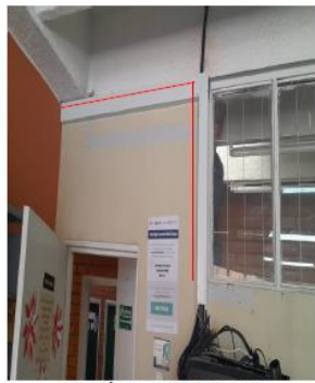
Ilustración 4. Recorrido de la canaleta.
