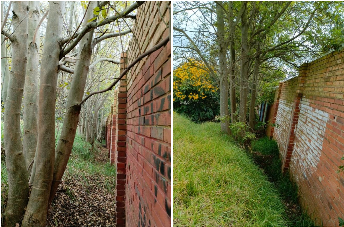
Fotografía 5 y 6, inclinación del muro.
