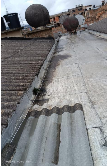
Ilustración 3. Ruta de cableado
