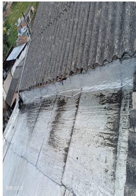
Ilustración 2. Ruta de cableado
