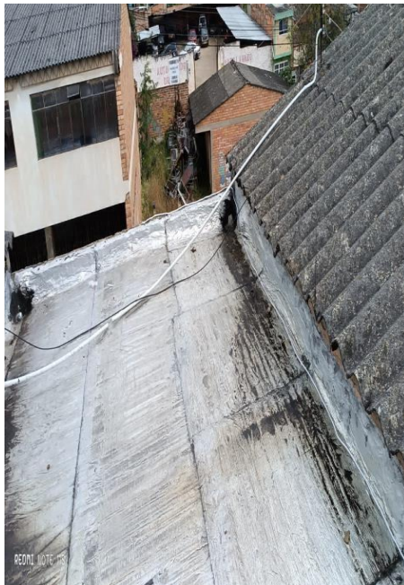
Ilustración 1. Ruta de cableado
