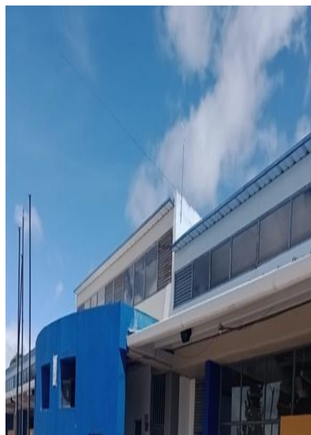
Ilustración 4. Renovación de antena
