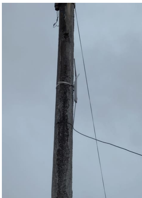
Ilustración 3. Renovación de la antena
