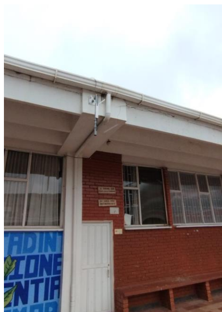
Ilustración 4. Renovación de la antena
