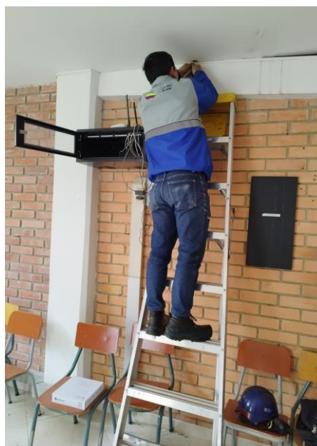
Ilustración 4. Instalación de equipo ONT
