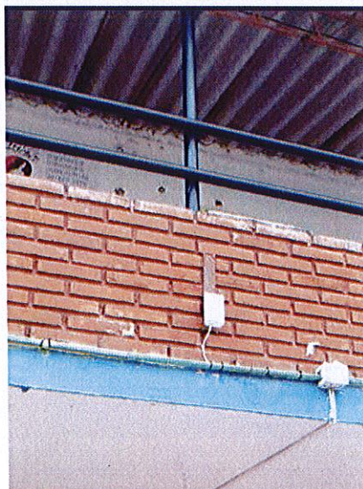
Ilustración 1. Dispositivo AP 2.4
