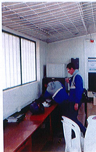
Ilustración 2. Instalación del router
